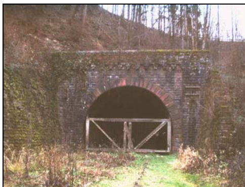
Tunnelportal Ost (Haseler Seite)
