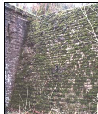
Flügelwand Tunnelportal West
