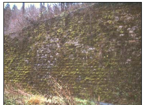
Flügelwand Tunnelportal Ost
