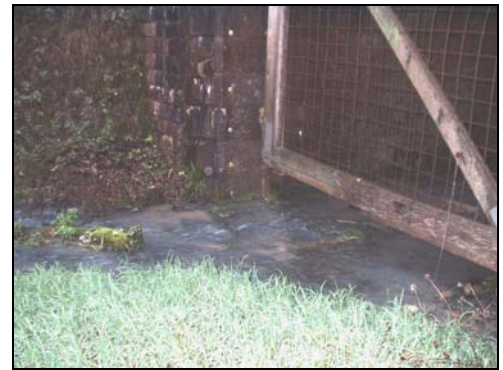
Austritt „Tunnelbach“ Haseler Portal
